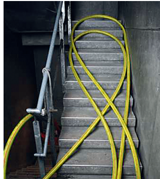
Abb. 25 Verlegen der Schlauchreserve im Innenbereich
